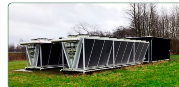
Varmepumpeanlæg ved Sig Varmeværk
